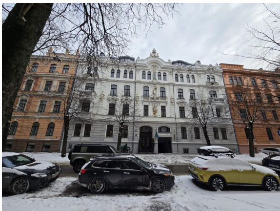
Ēkas fasāde no Ausekļa ielas
